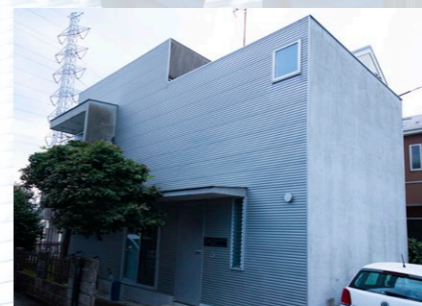
外壁にメンテナンスの負荷が少ないガルバリウムを使用した杉浦さんのご自宅。「10年以上経った今も、補修はしていません」
