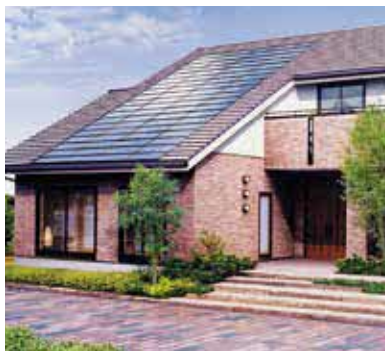
太陽光発電設備
