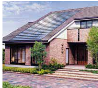
太陽光発電設備
