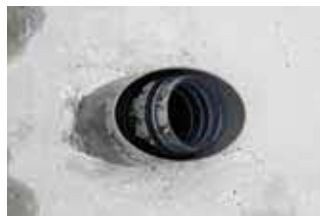
配管を二重にすることで、補修・交換を容易にした排水管の例
