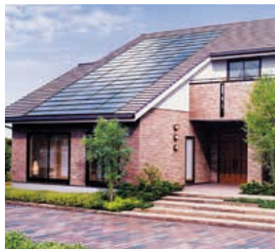
太陽光発電設備
